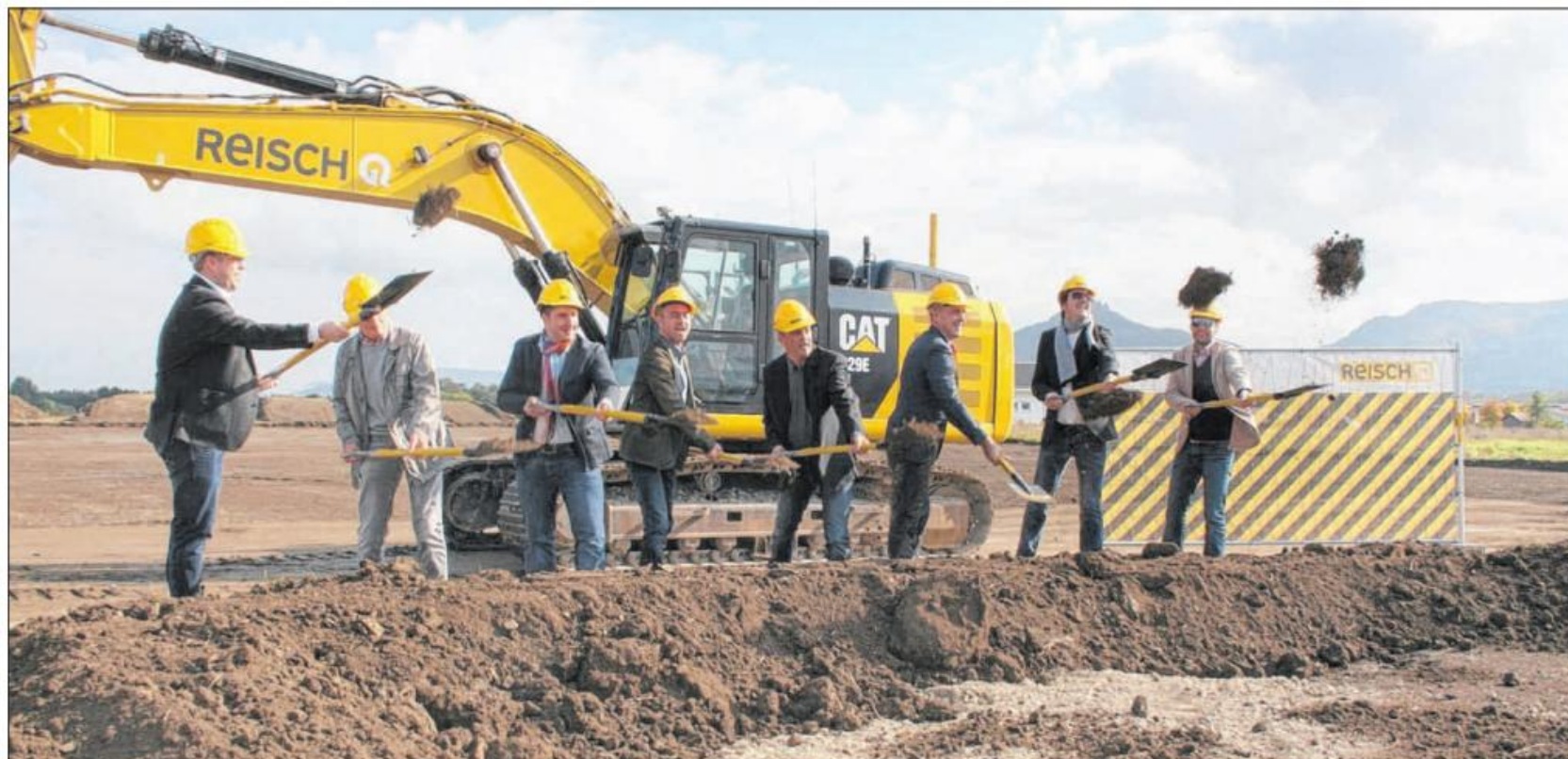
Und los geht's: Gestern war der Spatenstich für den Neubau der Firma Narr im Bisinger Gewerbegebiet Nord.
